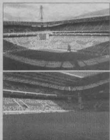
«Эштадью Жозе Алваладе» Место расположения: Лиссабон. Владелец: спортивный клуб «Спортинг». Вместимость: 50,466 зрителей. Архитектор: Томаш Тавейра. Дата открытия: 6 августа 2003 года. Стоимость строительства: 79.003.030 евро.
